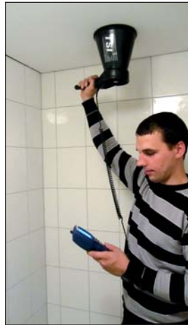
Messung am Deckenauslass
